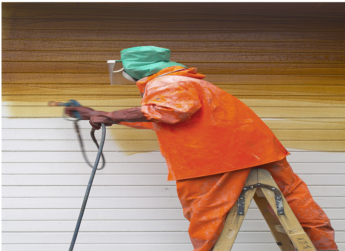
Hele huset er dekket med STS. Nå skal det stå natten over for å virke.
