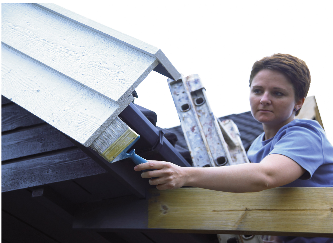
Endeveden på stående kledning mettes med tre strøk dekkbeis vått-i-vått.
