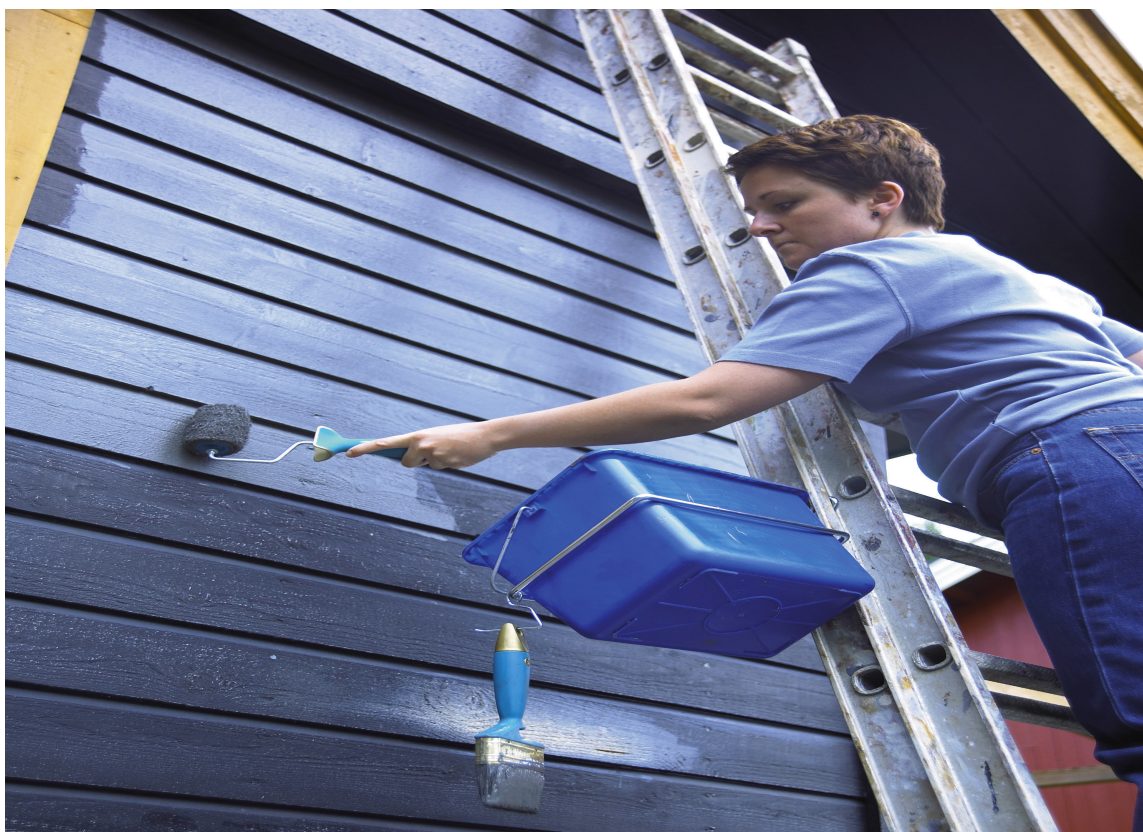
To strøk på vegg, og tre på vindskiene, vinduene og dører.
