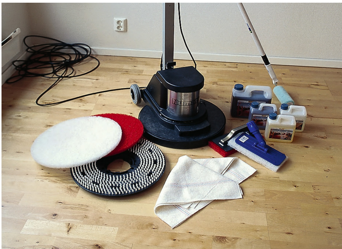
4. Når gulvet er ferdigslipt og støvsuget påføres oljen med malerrull på ett felt av gangen.
