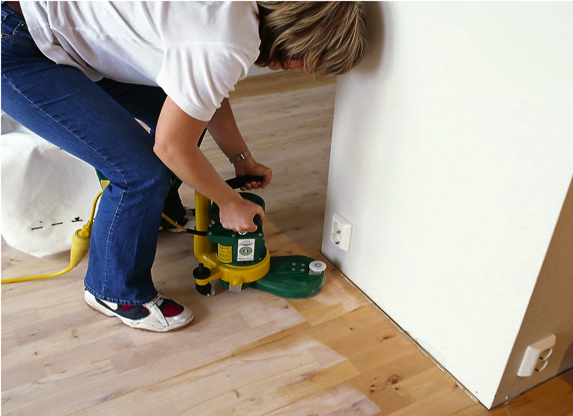
3. Utstyr til oljing av parketten: Malerrull og forlengerskaft, tregulvoljer, poleringsmaskin med røde og hvite pads, håndpads og bomullskluter.
