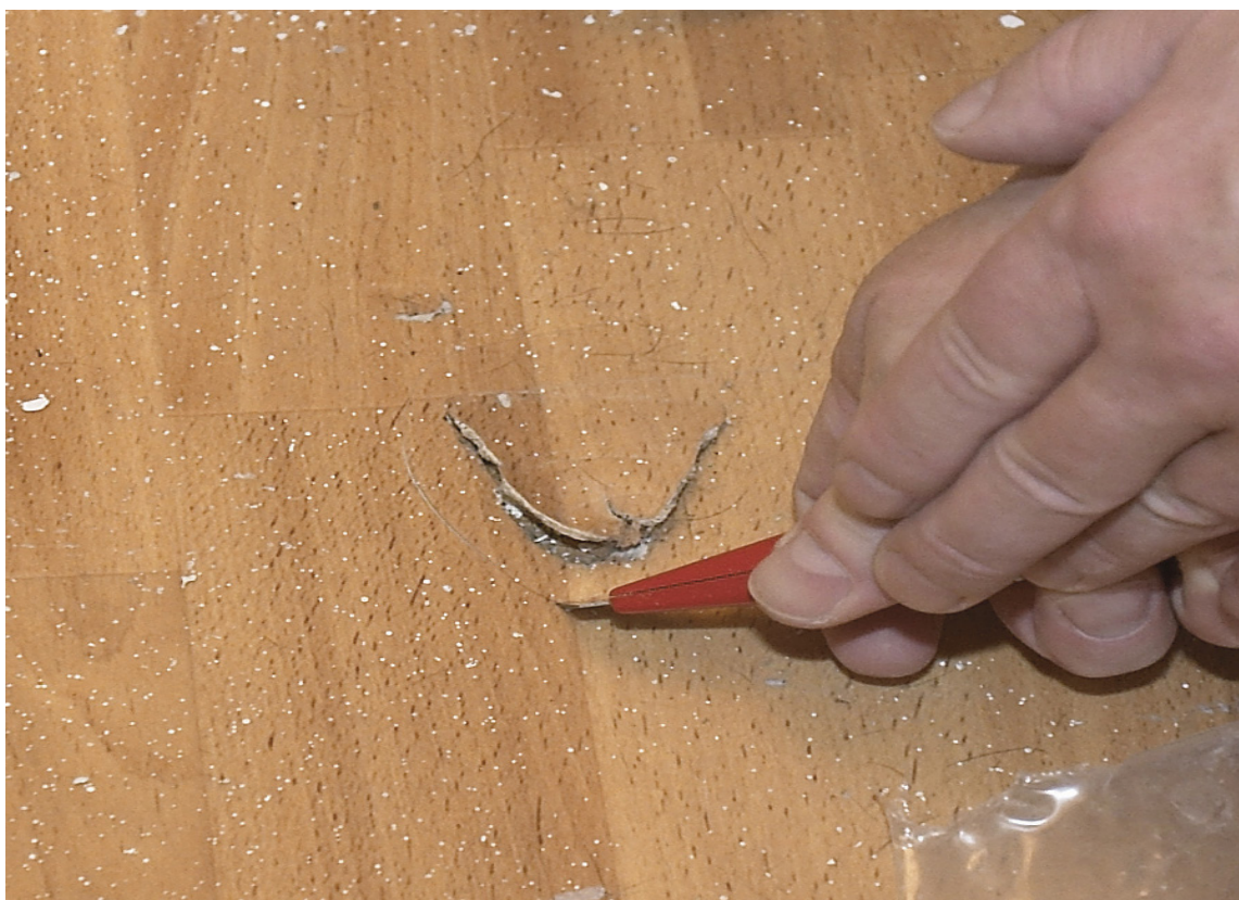
4. I eldre boliger vil gulvene ofte ikke være helt plane - spesielt kan det merkes langs veggene. Slike skavanker bør rettes før gulvlegging.
