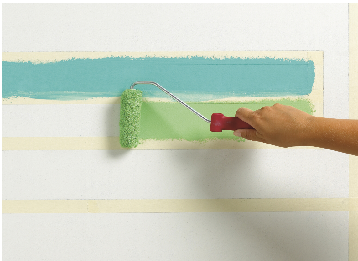
8. Dra maskeringstapen av umiddelbart etter at du er ferdig med å påføre malingen. Det er viktig å dra den av før malingen tørker for å unngå "sårkanter".
