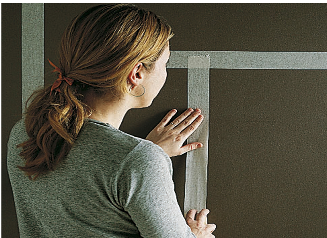
4. Mal panelene, første strøk i samme farge som vegg, men med en høyere glans. Fjern maskeringstapen mens kantene på panelet fremdeles er våte. Malingen dras lett av hvis du lar
