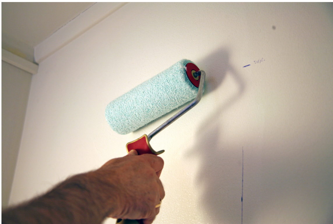
LIM PÅ VEGGEN: Limet påføres på veggen.
