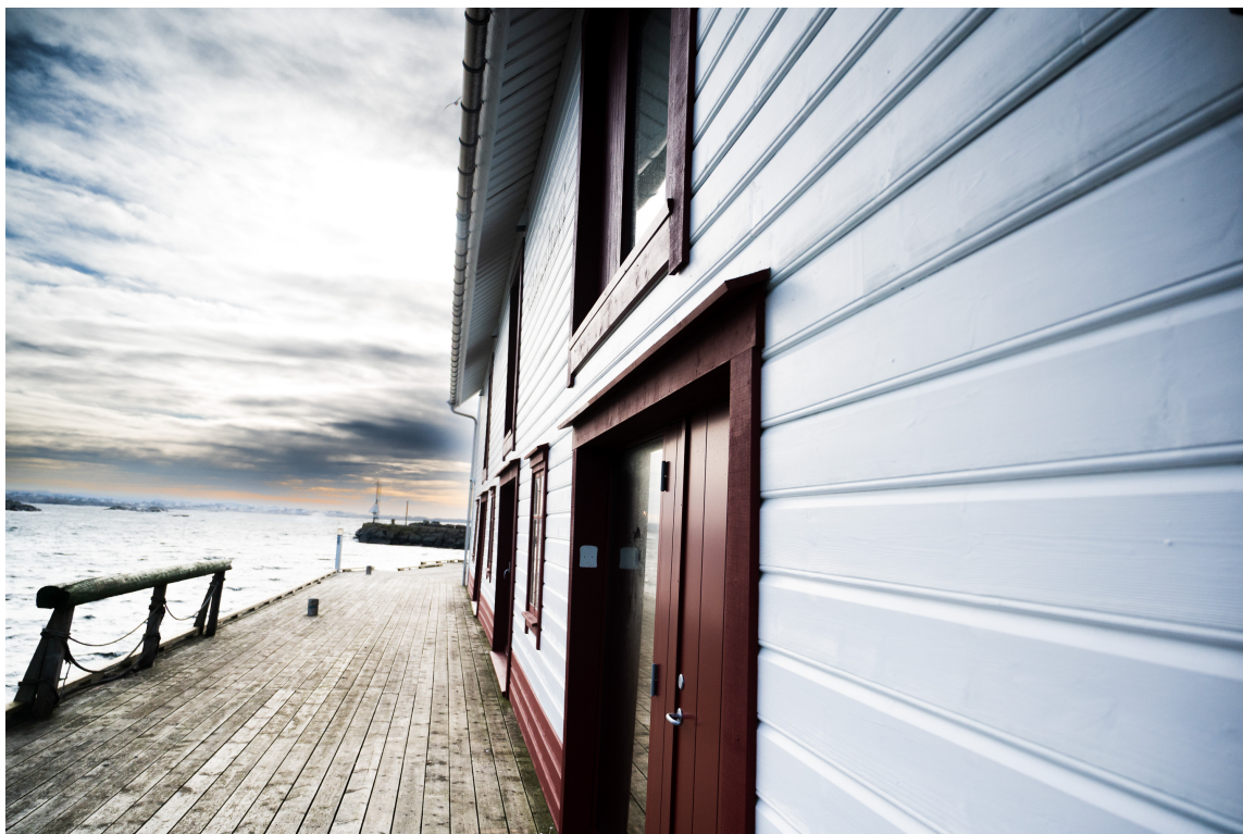
HOLDBAR TREBESKYTTELSE: Beliggenheten ytterst mot havet krever en trebeskyttelse som tåler regn og sjø som pisker på veggene. Valget falt på et system med Wood Tex fra den lokale Flügger-butikken.
