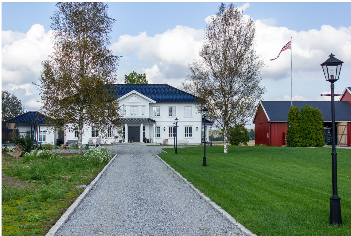
GÅRD: Kontrasten mellom hvitt hus, rød låve og grønt rundt gir et klassisk norsk gårdsuttrykk, der det nye huset tydelig fungerer som hovedhus og blikkfang på tunet.
