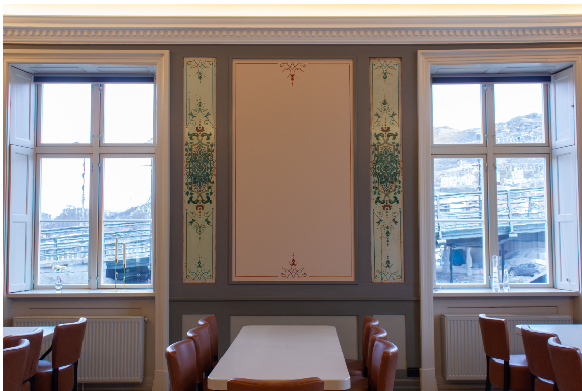
HISTORISK VEGGDEKOR: Restaurert vegg i Kongegården. Sidefeltene er renset frem, mens midtfeltet er rekonstruert med jutestrie, maskinpapir og linoljemaling fra Engwall o. Claesson, med dekor inspirert av de originale feltene.
