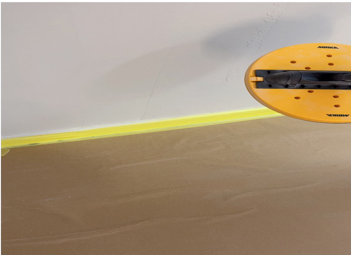
MED STØVSUGEREN: Med støvsugeren koblet til fanges slipestøvet opp underveis, og mengden støv i rommet blir minimal.
