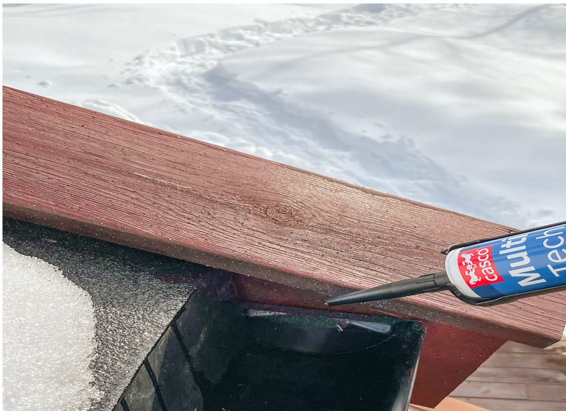
TETTER TAKRENNNA: MultiTech fra Casco fungerer til både fuging og liming – også i kaldt vær.
