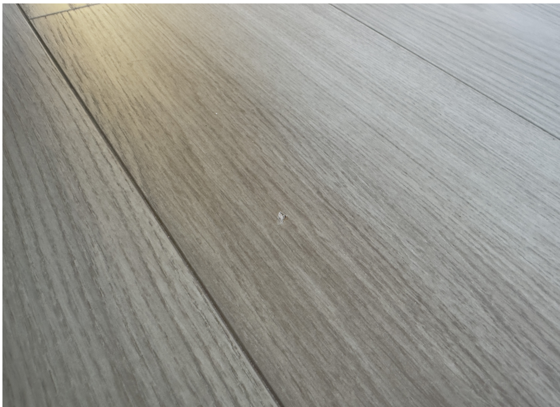
RAMMER ALLE: En løs bilderamme landet rett i gulvet og etterlot et synlig hakk – en typisk skade som enkelt kan repareres.
