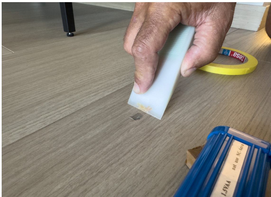
SKRAP: Skrap bort overflødig voks med skrapen som følger med i settet, slik at reparasjonen blir jevn med gulvoverflaten.
