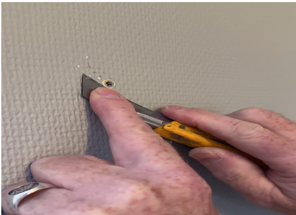
UJEVNHETER: Fjern skruer, skruehull og alt som stikker ut for en jevn og fin overflate før du setter i gang og påfører limet.
