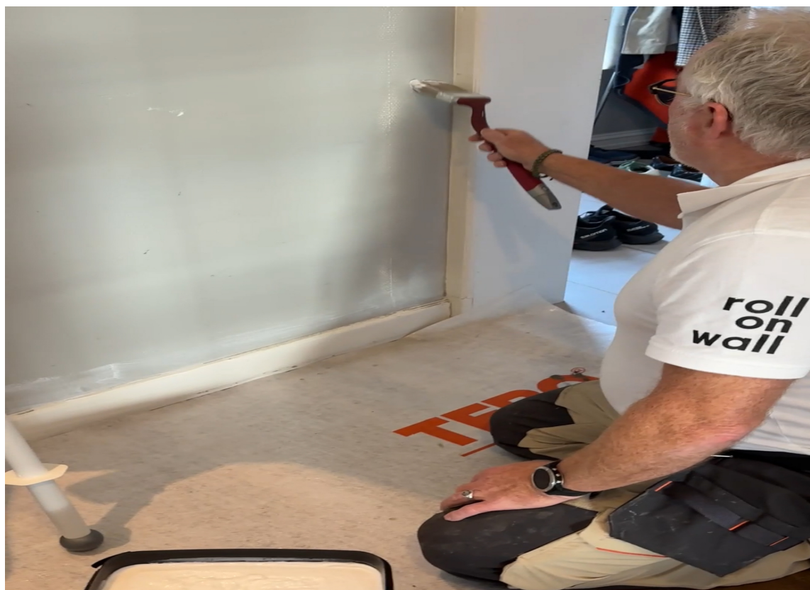
PÅFØRE: Bruk en radiatorpensel til kanter og en rull med forlengerskaft på store flater for en jevn og effektiv påføring av limet.
