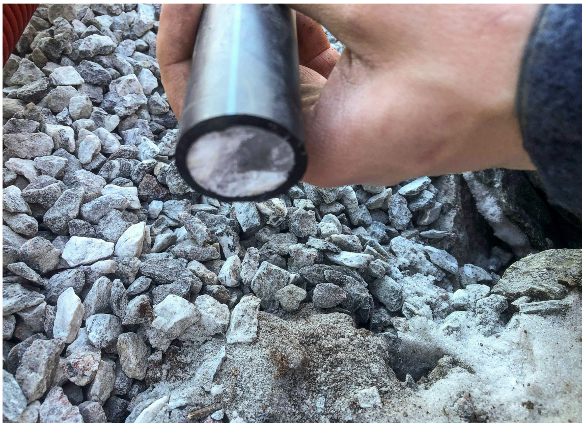
FRYST: Det kommer ikke mye vann gjennom det røret her.
