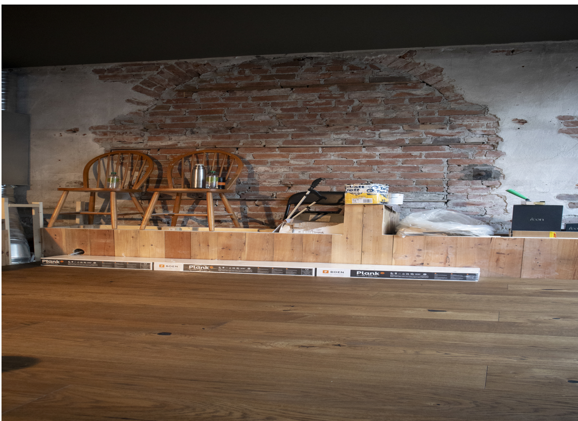
FERDIG: Med gulvet på plass kan Tiedemands nå få på plass møbler og interiør, og den nye baren er ett steg nærmere åpning.
