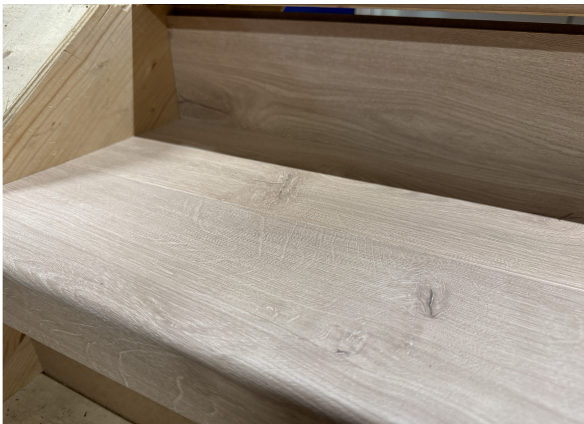
FIRE DELER: De fire delene du trenger for å fornye trappen er trappenesen, et tilpasset laminatbord, en forlenger, og opptrinnet. Opptrinnet limes på vertikalt mellom stegene.
