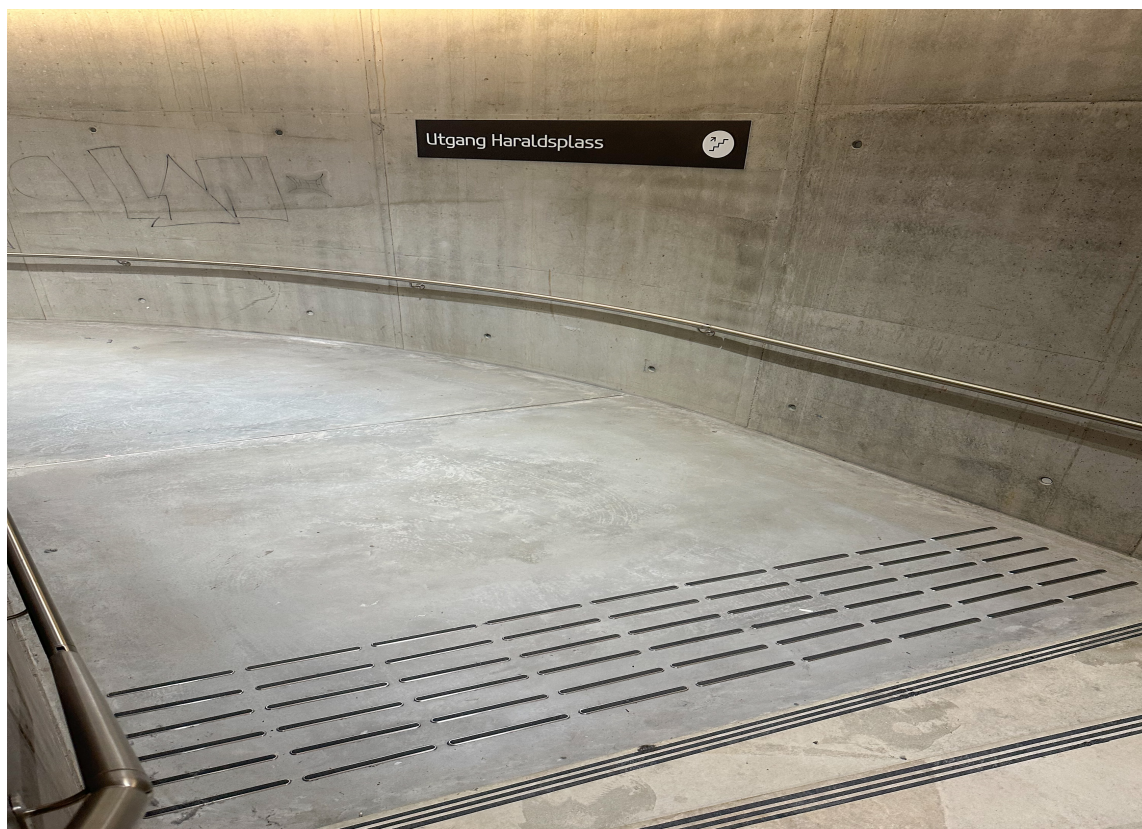
VARSELFELT: Varselfelt forteller svaksynte om nærvær av trapper, og gir tydelige visuelle og taktile signaler som bidrar til økt sikkerhet ved bevegelse i offentlige og private rom.
