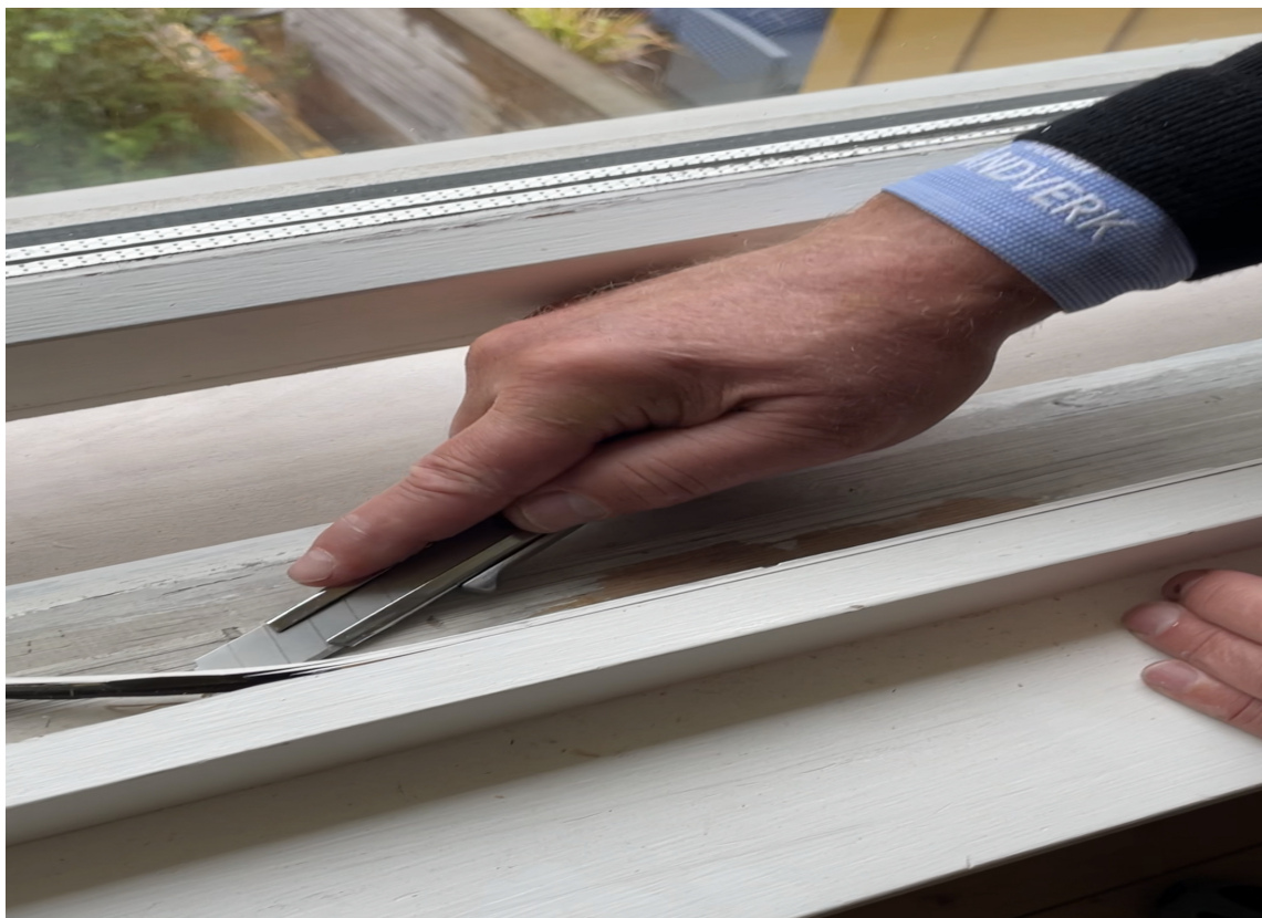
FJERN: Å skjære vekk de gamle tetningslistene gjør du lettest med en skarp kniv.
