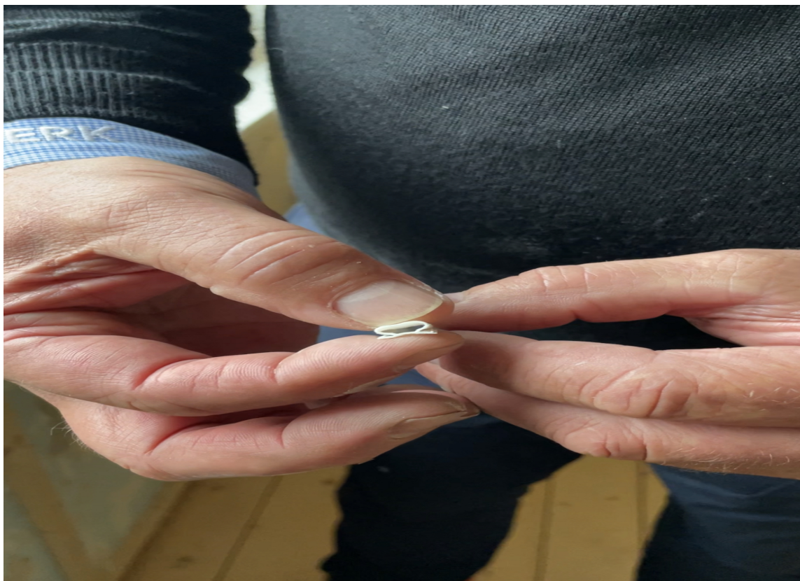
FLEKSIBEL: En tetningslist som dette kan flekse mellom syv og én millimeter. Det gjør den til et godt valg for gamle vinduer.
