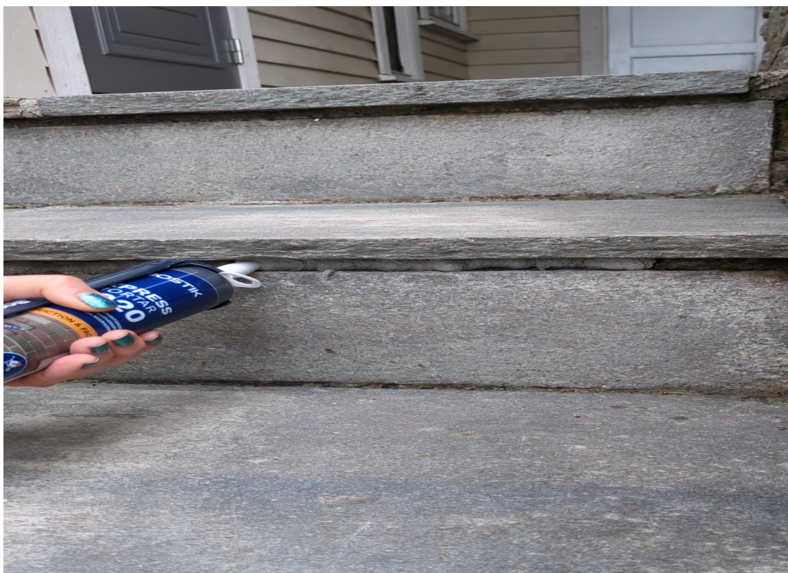
FORT GJORT: Reparasjonsmassen er enkel i bruk, og herder relativt raskt.
