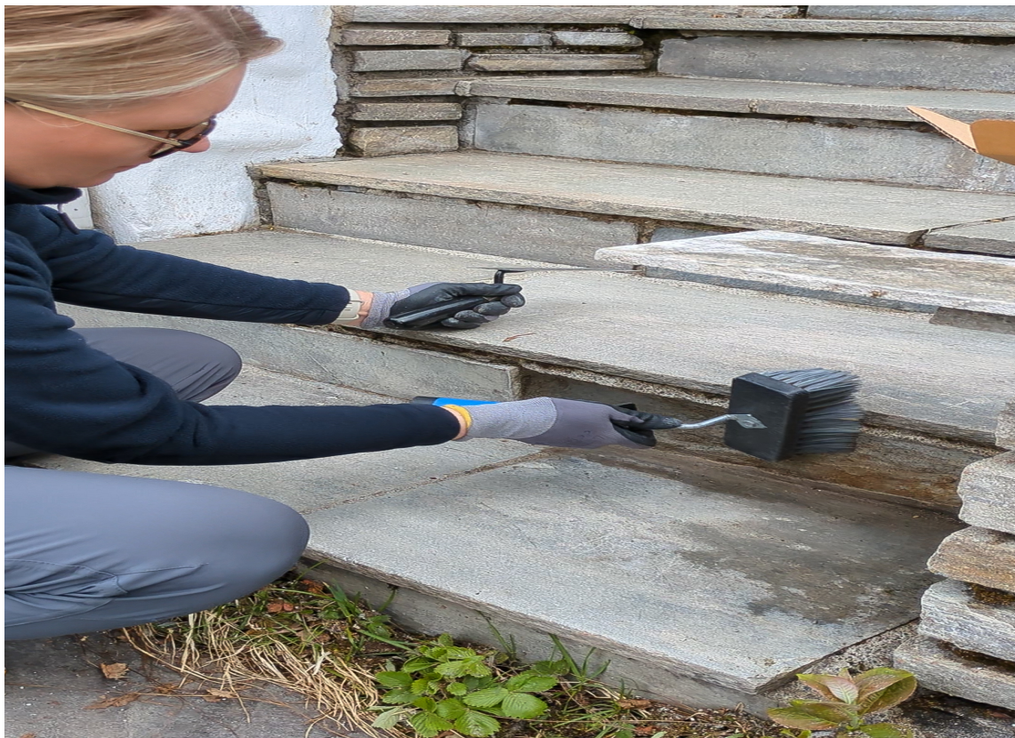
RENGJØRE: Start med å vaske og rengjøre området som skal utbedres. Skitt og løse deler må bort.
