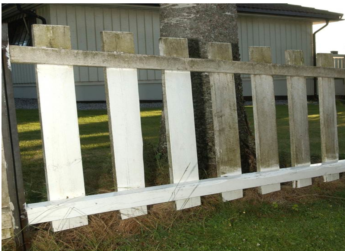
SE: For en forandring! Gjerdet så ut som det måtte males umiddelbart. Det var kun en vask som måtte til. Gjør du dette årlig kan du spare deg for mye maling og kostnader.
