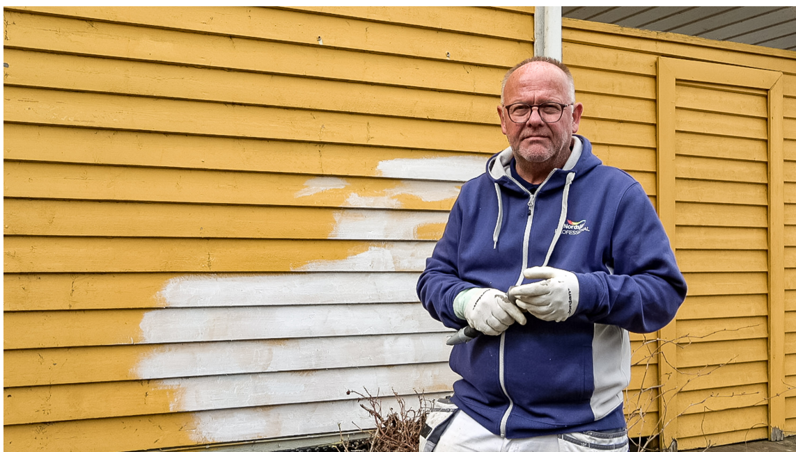
FINNER VEIEN: – Vann finner alltid en vei inn: ved endeved, kuttflater, detaljering ved vinduer og plattinger med kledningen helt ned til terrassegulvet, sier Per Myhre, teknisk sjef hos Nordsjö.
