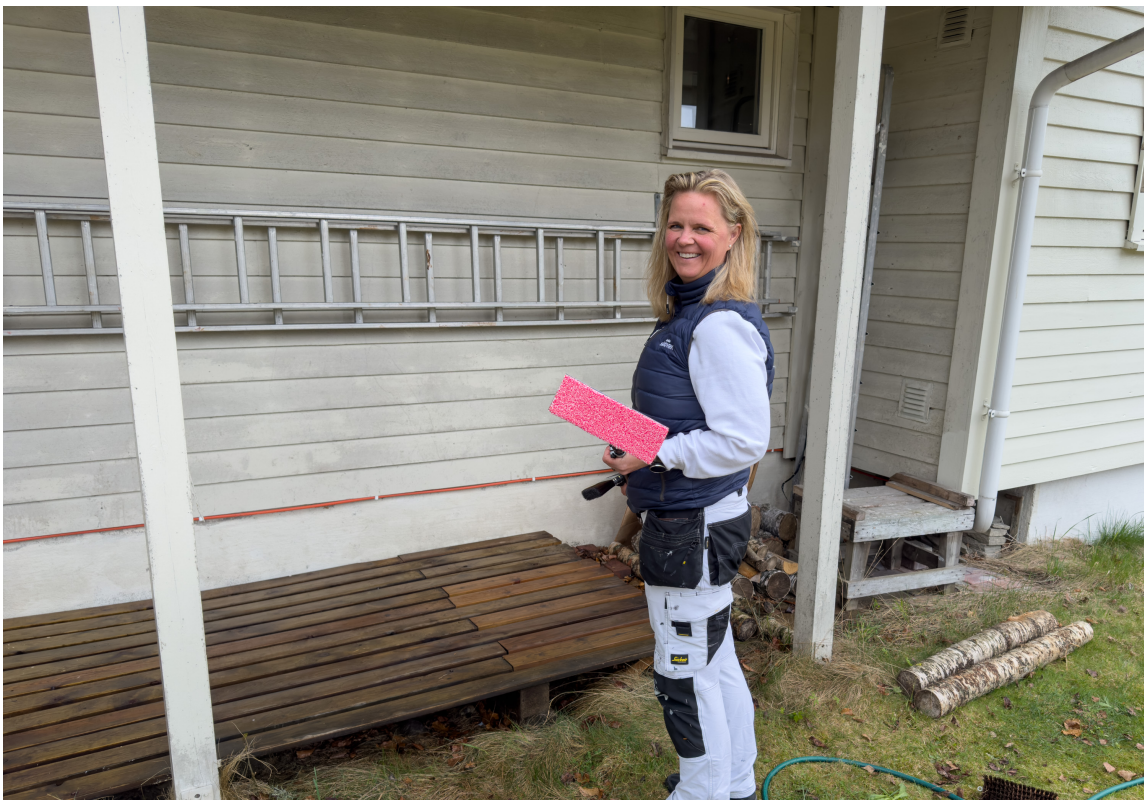
VASK VEGGEN: Når du først har ryddet unna er det like greit å også vaske husveggen bak terrassen tipser Åsa Schaanning hos Jordan.
