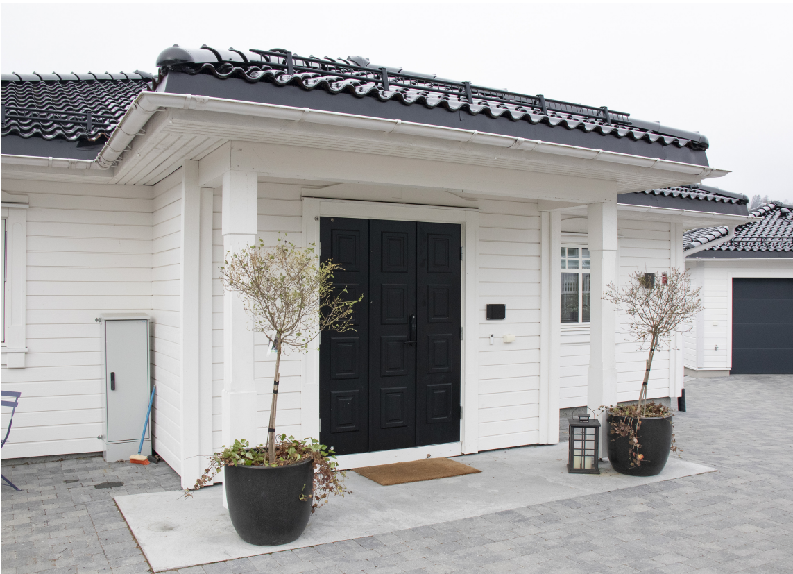
HVIT FASADE: Jo lysere farge på huset, jo lettere er det å se skitt og sopp på veggen.
