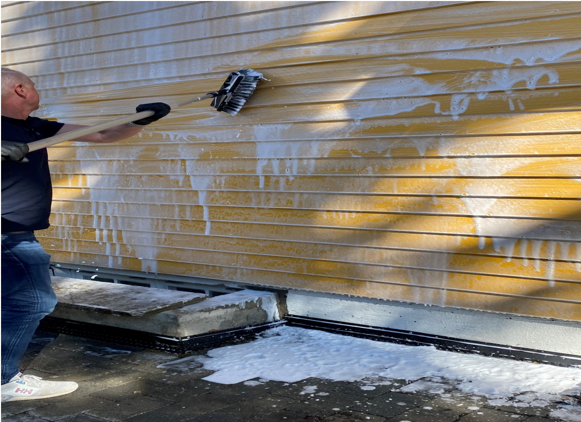
HUSVASK: Etter Husvasken ser du hva som er møkk og hva som er begynnende flassing.
