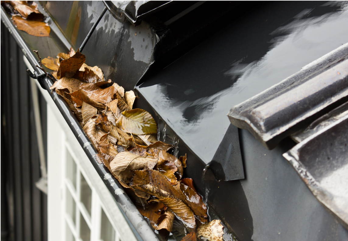
TAKRENNNA: Ta en kikk på taket og se etter mose, begroing, rusk i takrenner, og undersøk malingen på vannbrettene.
