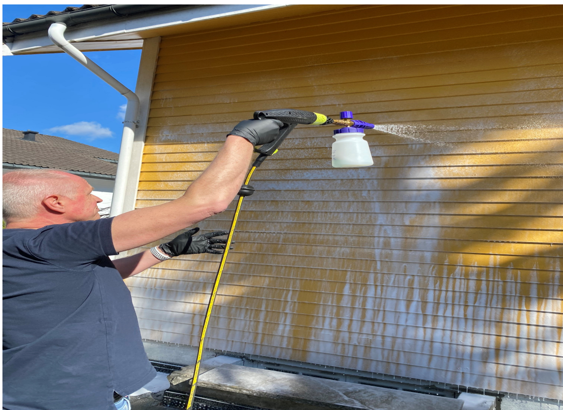
SKUMKANON: En skumkanon er genial for å påføre skumvask på fasaden. Skumkanonen kan kobles til en høytrykksspyler for enkel påføring.
