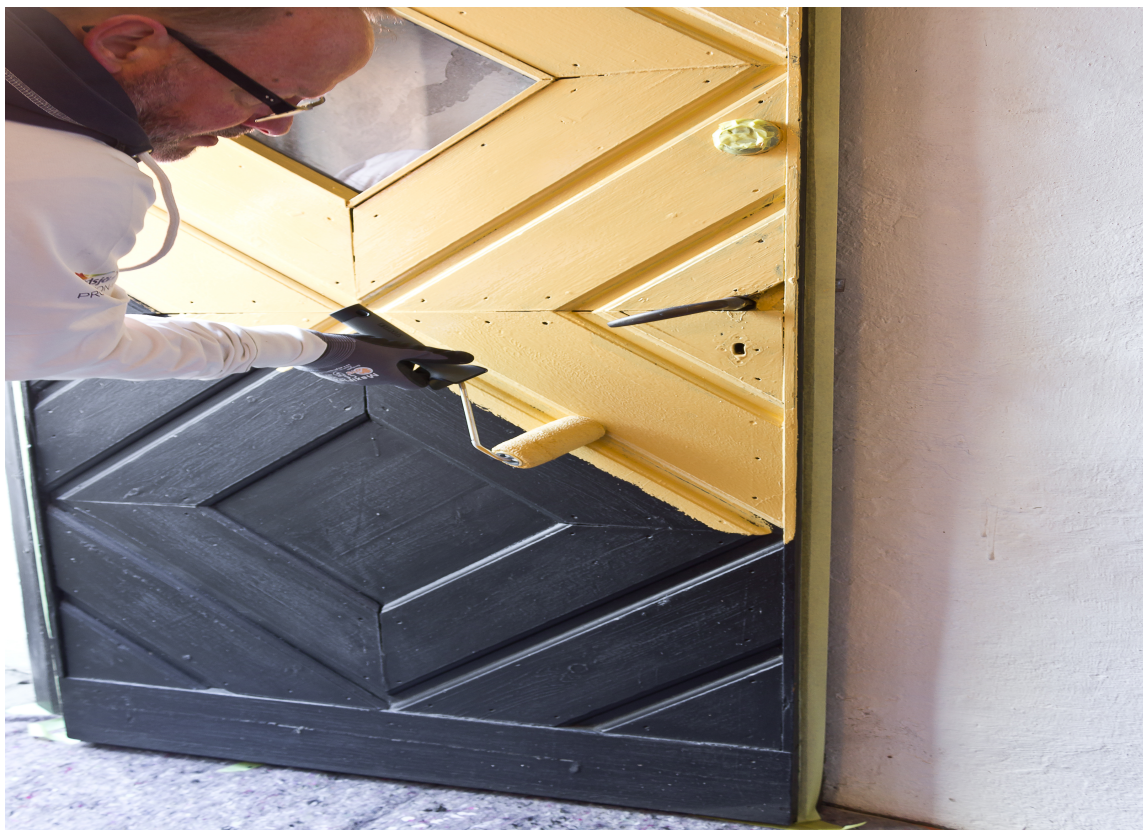
2 STRØK PÅ 1 DAG: Her er det brukt en hurtigtørkende dør- og vindusmaling. Det ble faktisk malt to strøk i løpet av samme dag.
