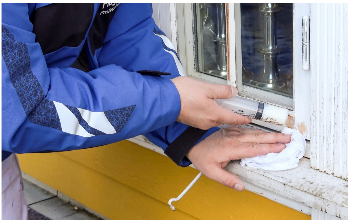
GRUNNINGSOLJE: Den tynne grunningsoljen trenger godt inn i treverket beskytter det mot fukt. Ikke hopp over denne!
