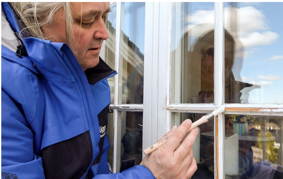
GRUNNINGSMALING: Primeren i Flüggers malingsystem for vinduer er valgfri, men den har flere fordeler. Blant annet fyller den ut ujevnheter mellom bart tre og gammel maling, og den gir toppstrøket ekstra god vedheft.
