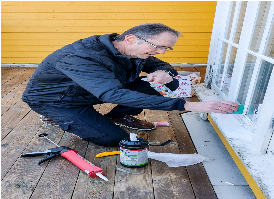
TILPASS: Bruker du fugeglattere, kan du måle opp med nabofugen når du skal finne ut av hvilken vinkel som blir best.
