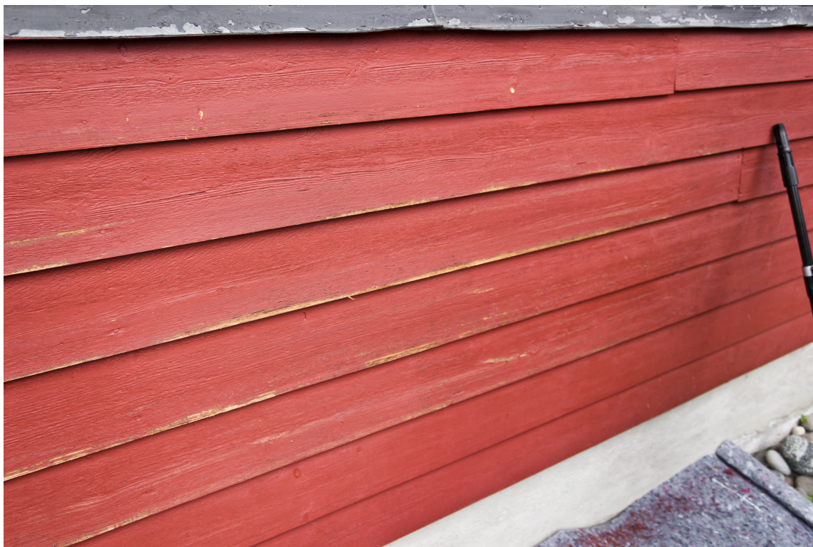
GRUNNING: Bort treverk skal alltid grunnes før du maler.
