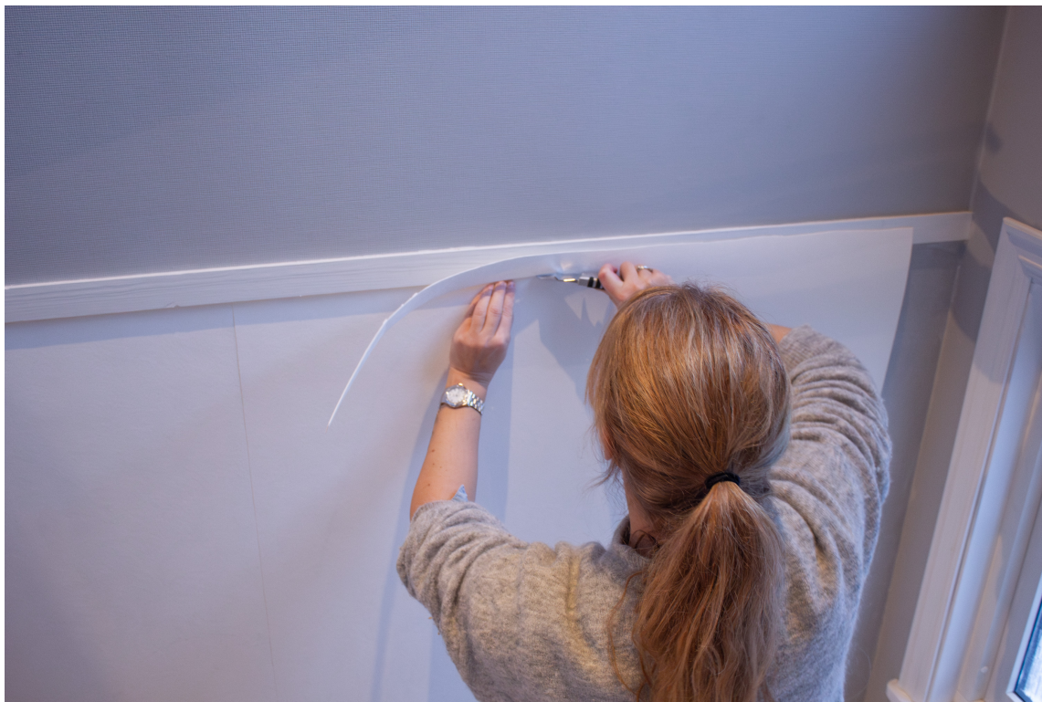
SLETT VEGG: For å slette ut glassfiberstrien før tapetsering ble det brukt Roll on Wall. I tillegg til strietapet kan Roll on Wall brukes på profilert panel, murvegger og andre ujevne overflater.
