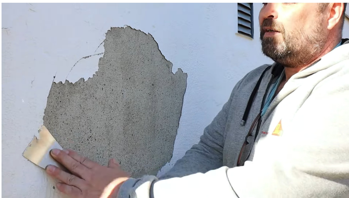
LØS PUSS: Før du kan reparere det skadede området bør du skrape bort løs puss.
