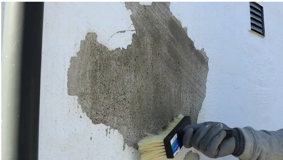
FORVANN: Vannet aktiviserer bindingen mot sparkelen som legges på slik den hefter til overflaten.
