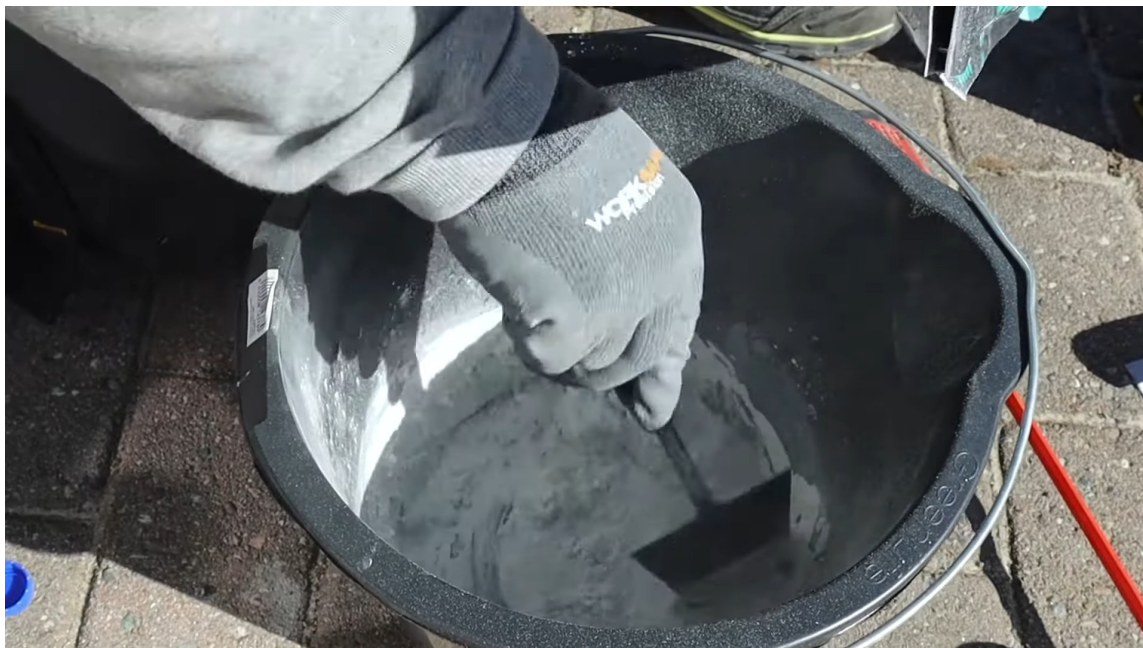
RØR SAMMEN: Bruk gjerne en visp til å blande sparkelmassen. Til mindre jobber kan du benytte en murskje.
