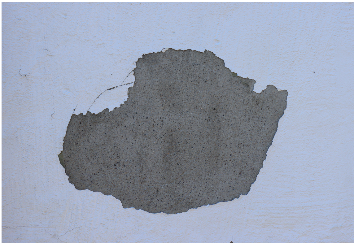
GRUNNMURSKADER: Det nordiske klimaet kan være hardt og varierende, det kan ofte føre til små skader på grunnmuren
