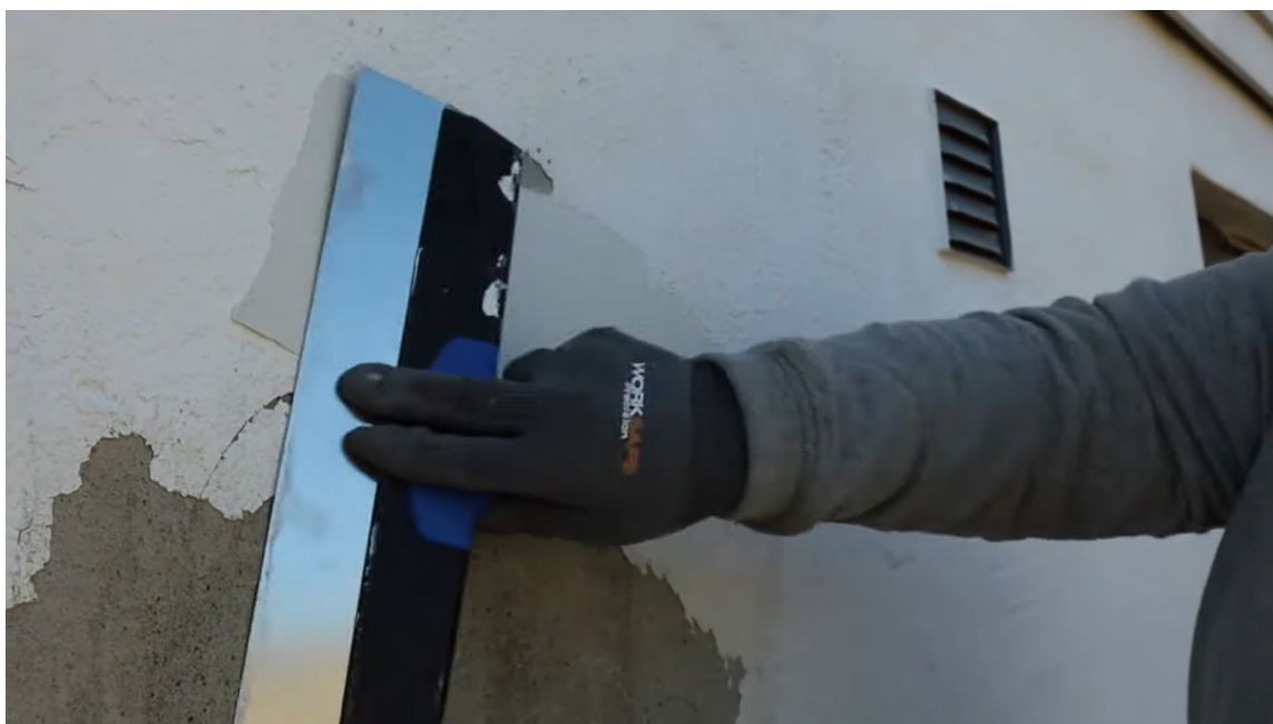
PÅFØR SPARKEL: Bruk en sparkelspade for å påføre sparkelmassen på murveggen.
