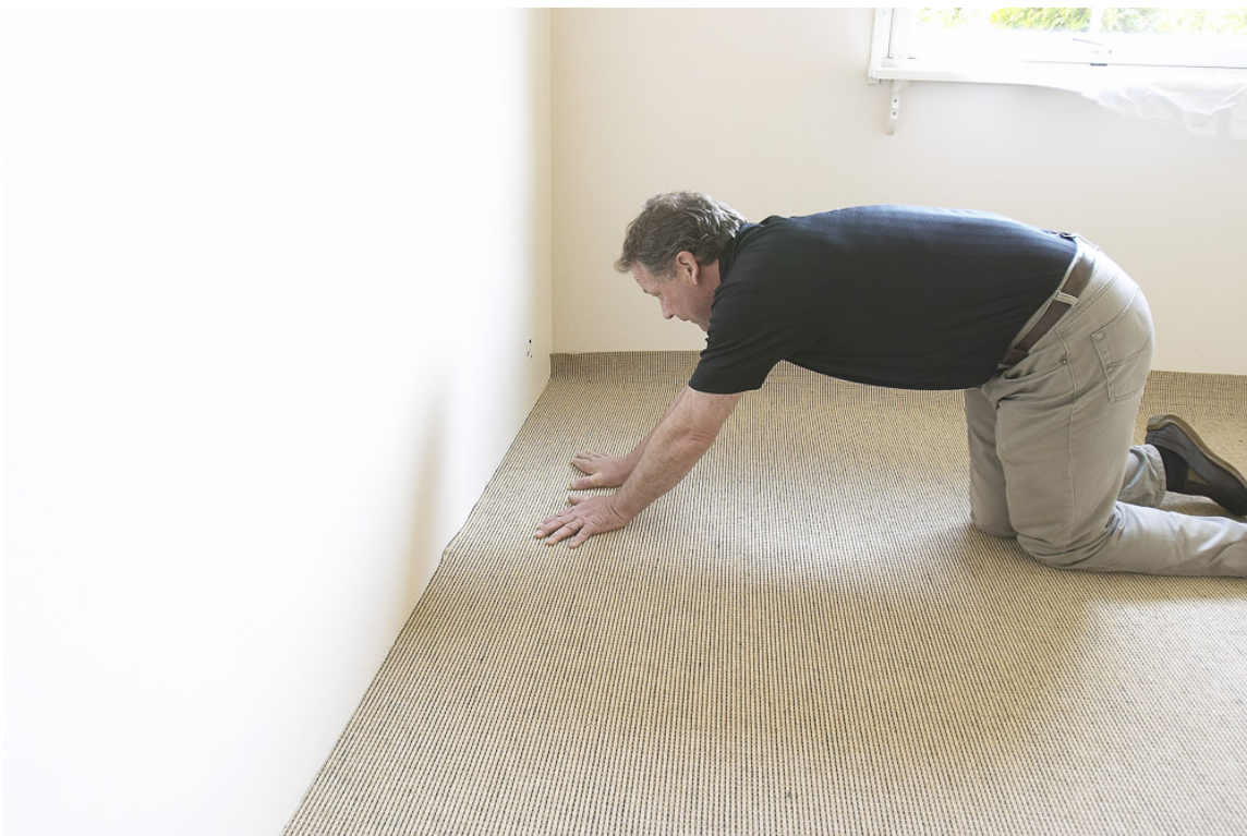
VEDHEFT: Stryk teppet godt på plass i limet. Har du tilgang til en gulvvalse brukes denne i både lengden og bredden.
