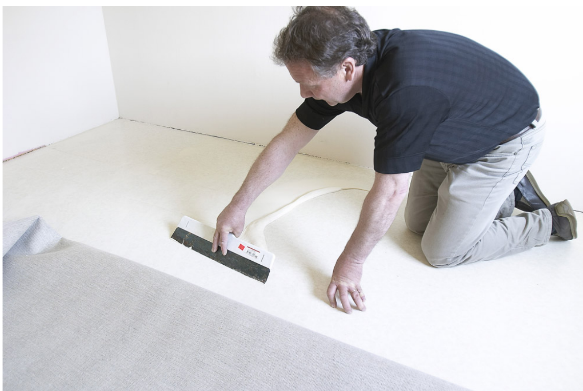
LIMING: Følg anvisningene fra lim leverandør i forhold til limtype, lim mengde og type limspreader.
