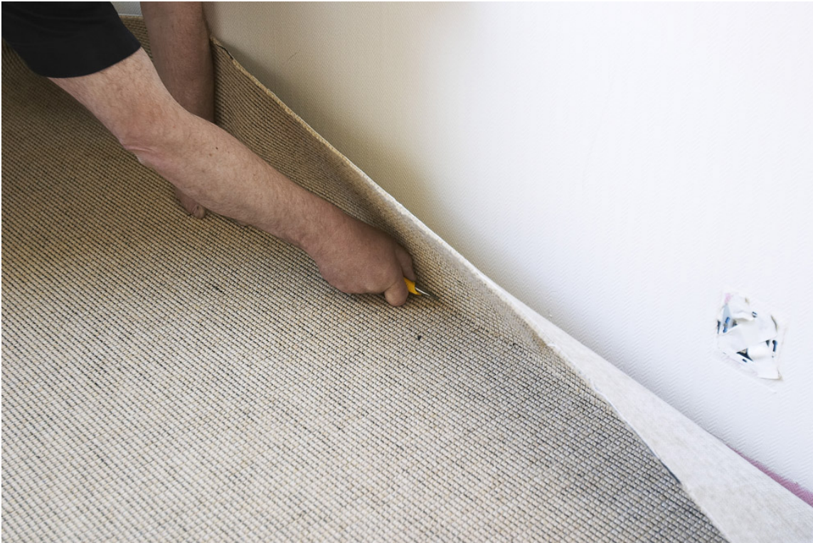
FINTILPASS teppet. Bruk en kniv med nytt blad.
