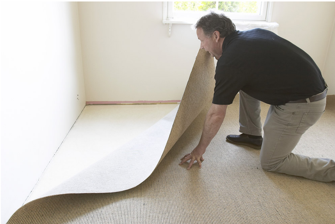
LEGG PÅ PLOSS: Brett teppet tilbake limet har fått riktig konsistens.
