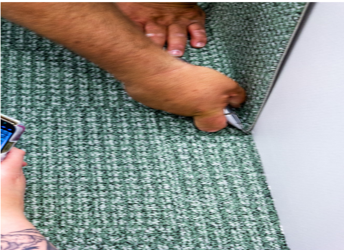
EN ANNEN MÅTE å tilpasse teppeflisen er ved å legge den vinklet opp langs veggen for å deretter kappe med kniven i hjørnet hvor veggen møter gulvet.
