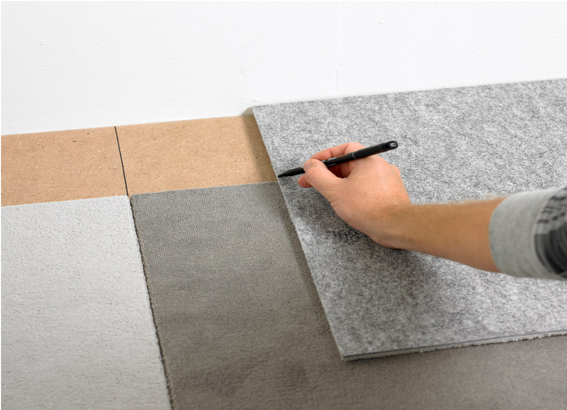
TILPASNING: Merk av på baksiden hvor bred den siste teppeflisen kan være, og kapp etter streken.
