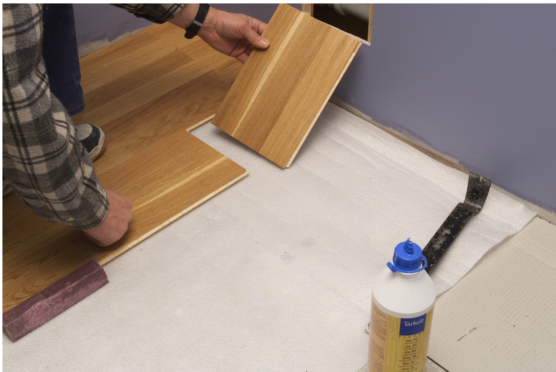
RAD 2 startes med det som ble igjen av siste bordet i den første raden.
