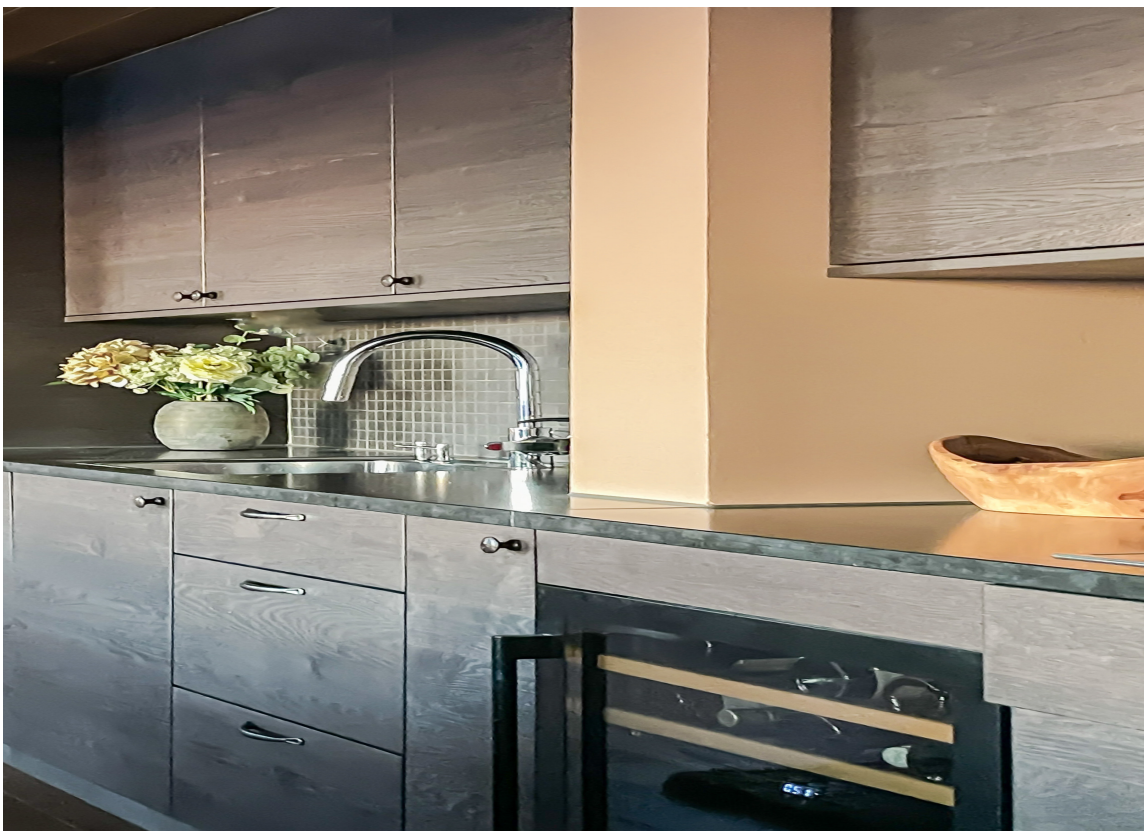
KJØKKEN: Skrogene på kjøkkenskapene ble beholdt, mens fronter og sidepaneler ble erstattet med en ny og spesialtilpasset variant i mørkt treverk.
