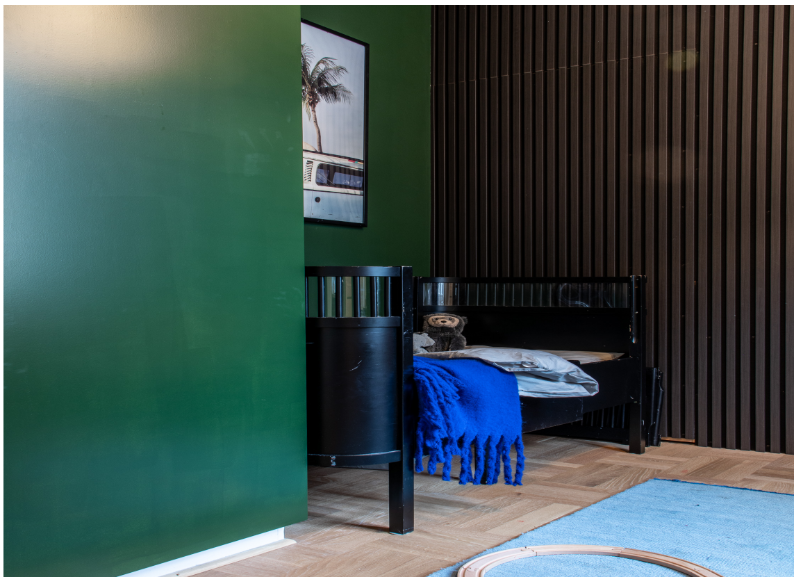
GUTTEROMMET har fått nytt parkettgulv og spilepanel med akustikkfilt demper lyder fra andre siden vegg der naboportens trappoppgang er. Vegg er malt i grønnfargen 869 Tallbarr fra Alcro.
