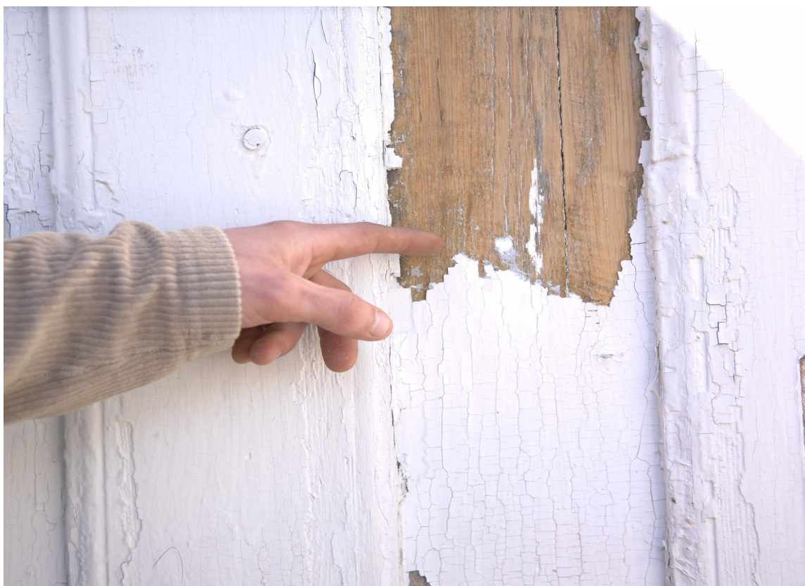
AVSKALLING: Her råder det liten tvil om at fasaden trenger et nytt strøk maling.
