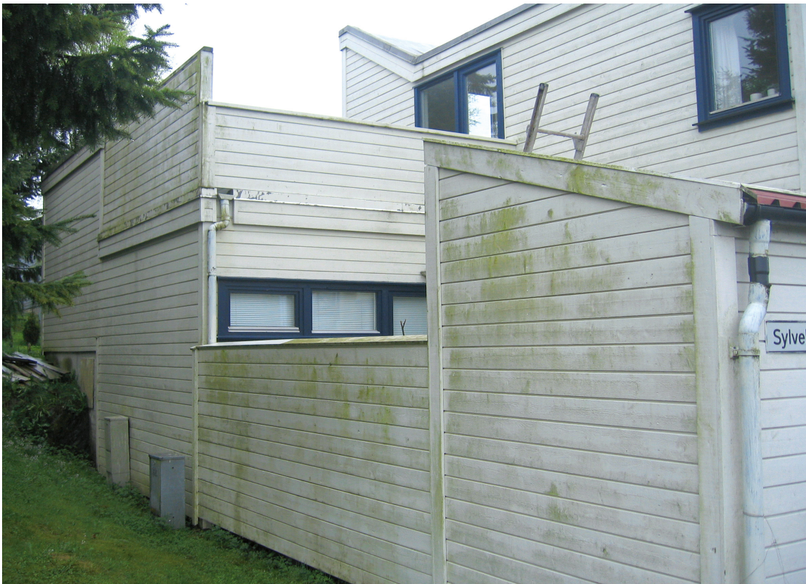
BEGROING: Vegger som tørker sakte og ikke varmes like mye av solen blir ekstra utsatt for begroing.
