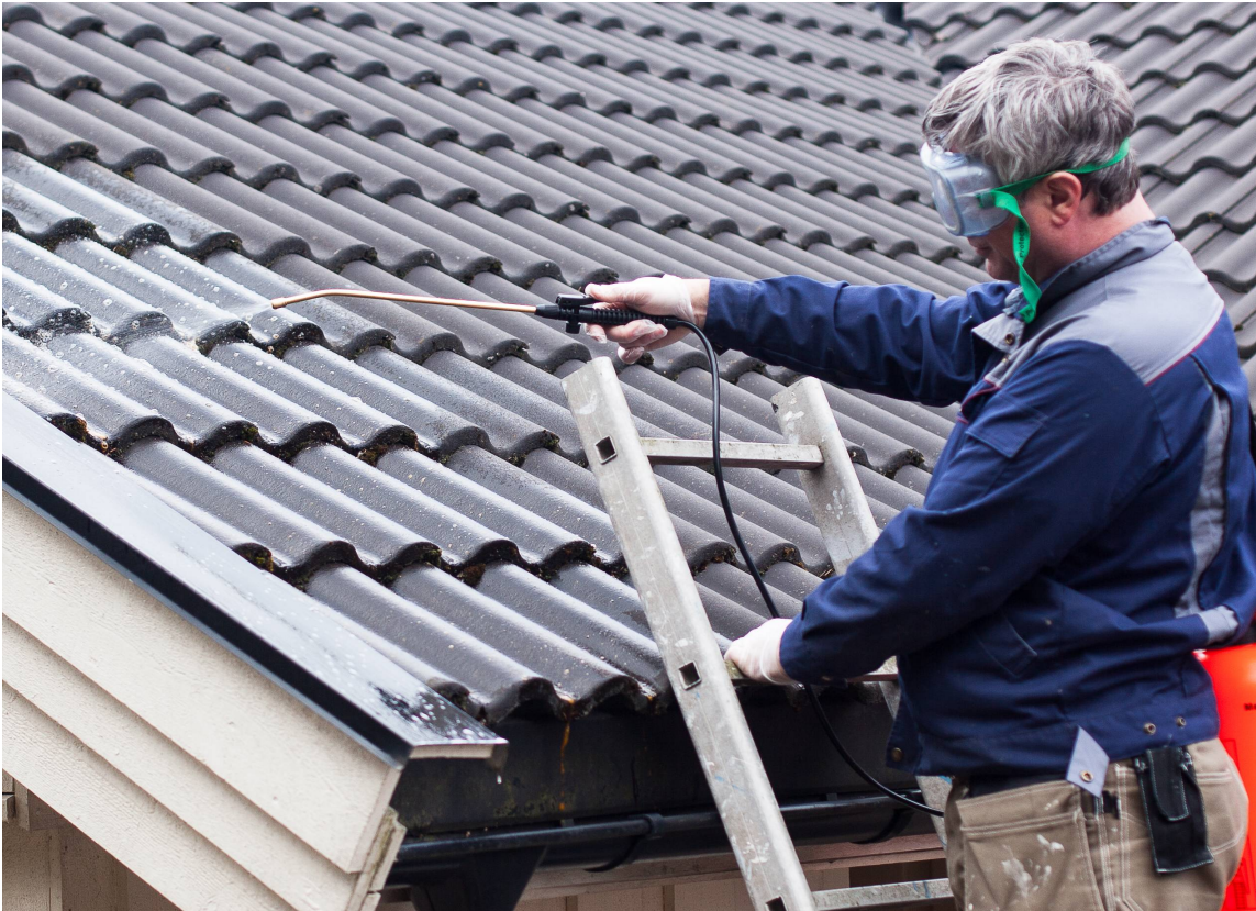
MIDDEL MOT SOPP OG ALGER: Sopp- og algedreper som husvask påføres ved hjelp av en spraykanne.
