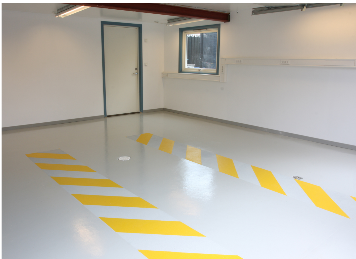
GULVET i garasjen skal tåle tøff belastning og vannsøl og salt. Der kan fugefrie gulv være en god løsning.
