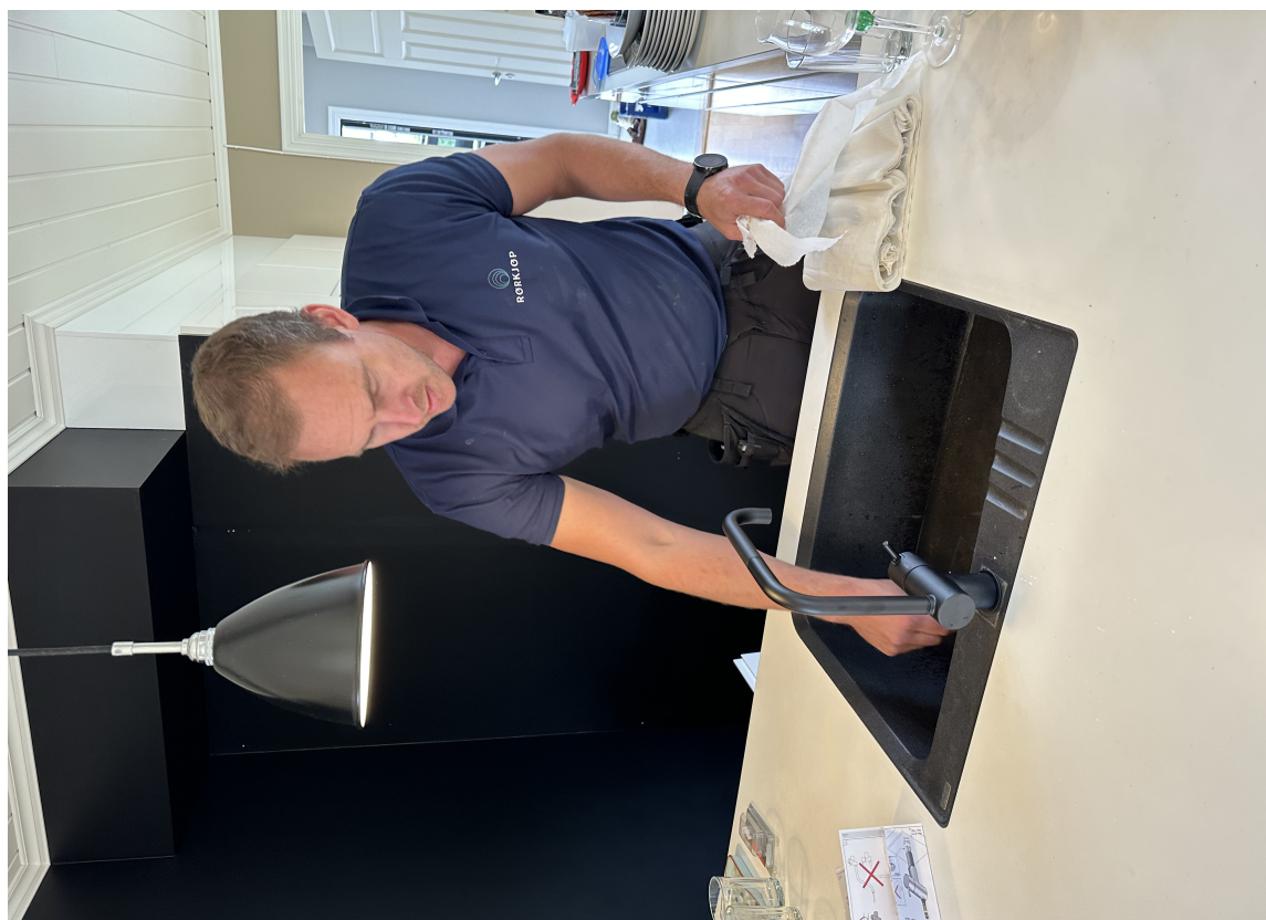
IKKE BARE RØR: Her er Andreas Lunde fra Nes Rør AS ferdig med å skifte en kjøkkenkran som lakk og sjekker at alt fungerer som det skal.
