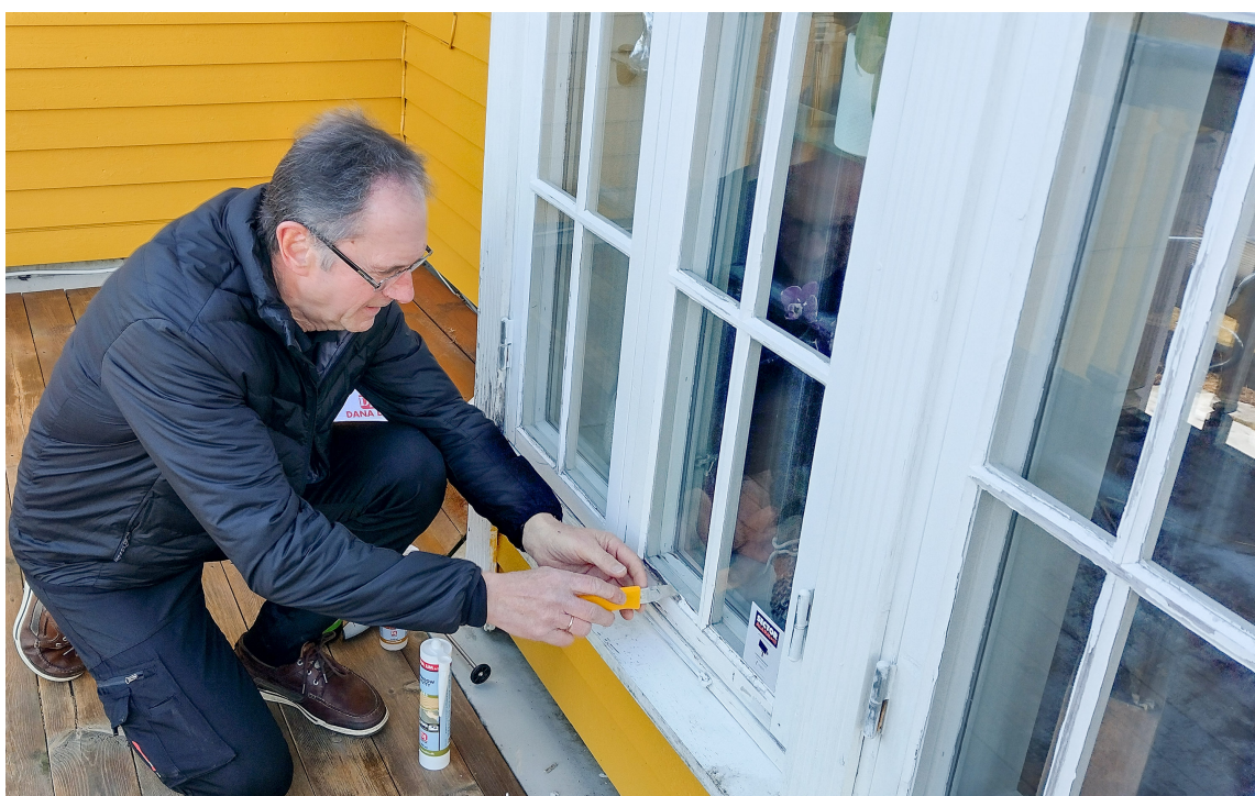
SKRAP BORT: Alt løst kan skrapes bort og fjernes.
