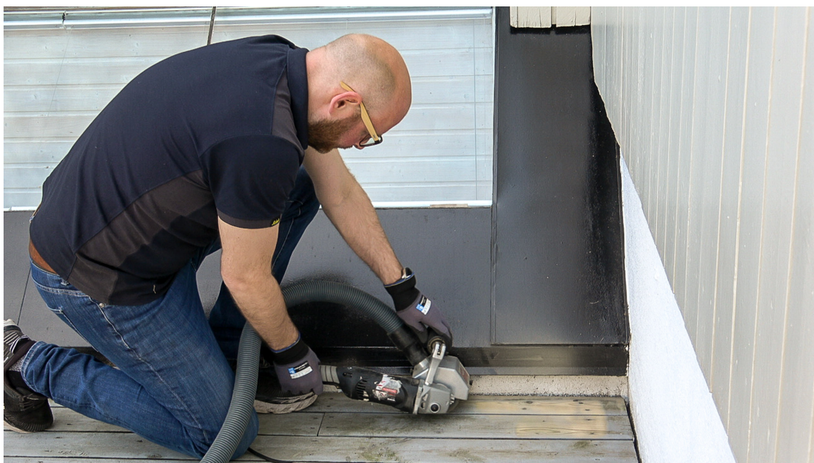
KANTSLIPEREN Randy brukes der du ikke kommer til med den store terrassesliperen.
