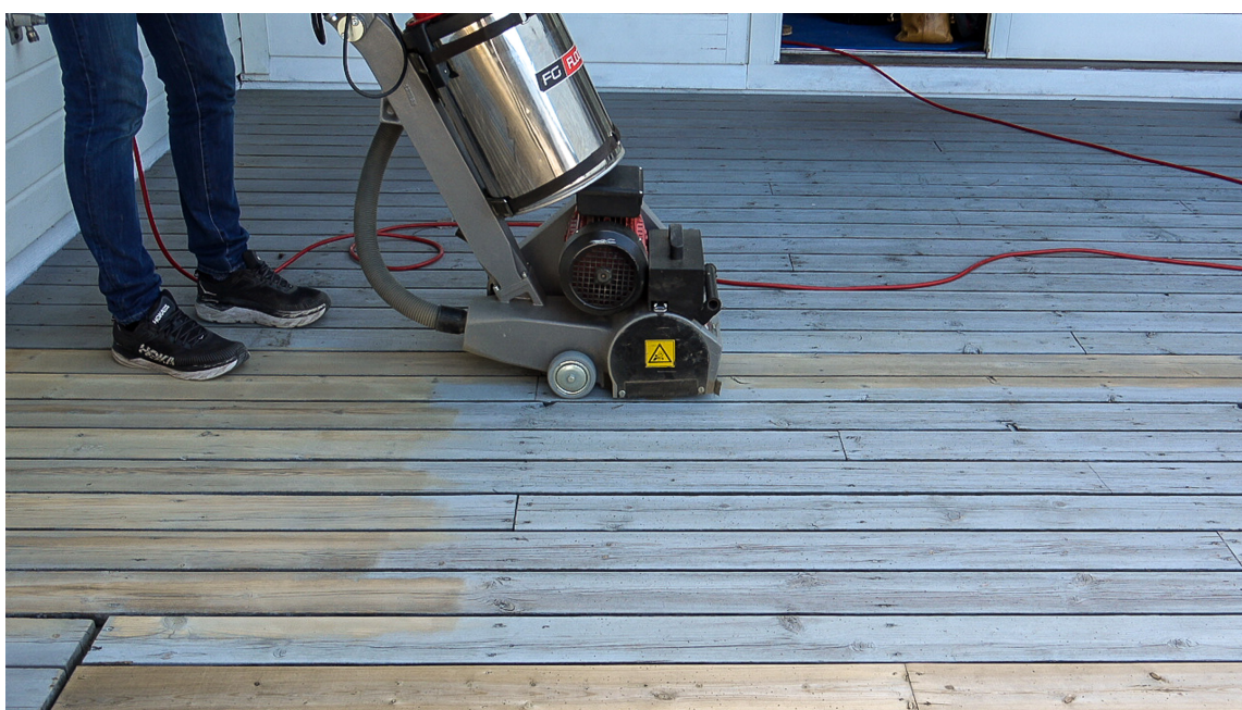
FJERNER TOPPSJIKTET: Nylonbørstene har korning 80 og sliper vekk toppsjiktet på treverket. Maskinen kan fjerne tørr ved og gammel beis. Har oljen eller beisen trukket langt ned i treverket, kan rester sitte igjen og påvirke resultatet når du overflatebehandler på ny.
