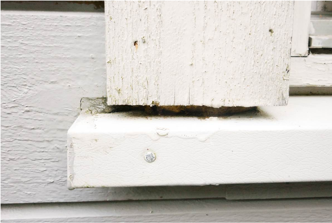
INSPISER: Spesielt vannbrettene er utsatt, så se nøye etter avflassing og om malingen fortsatt dekker alle kanter godt.
