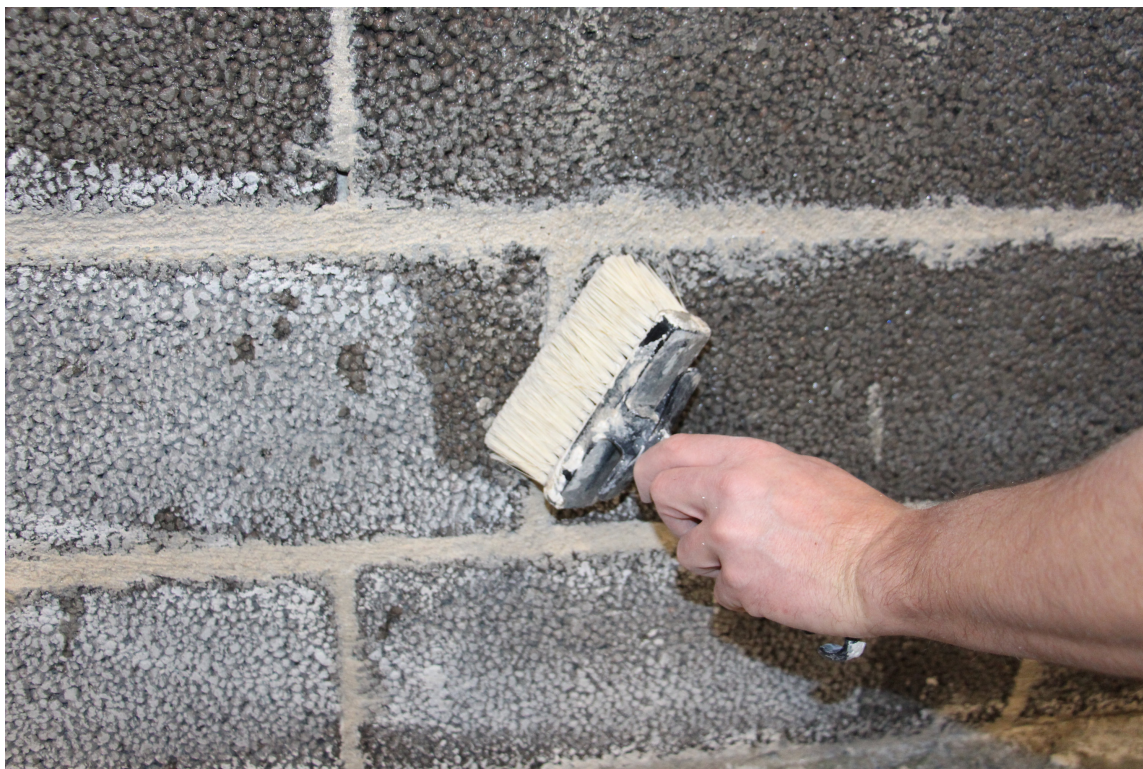
2. Forfukt underlaget med rent, kaldt vann eller påfør en primer. Dette gjør at pussene hefter jevnt og godt til underlaget.
