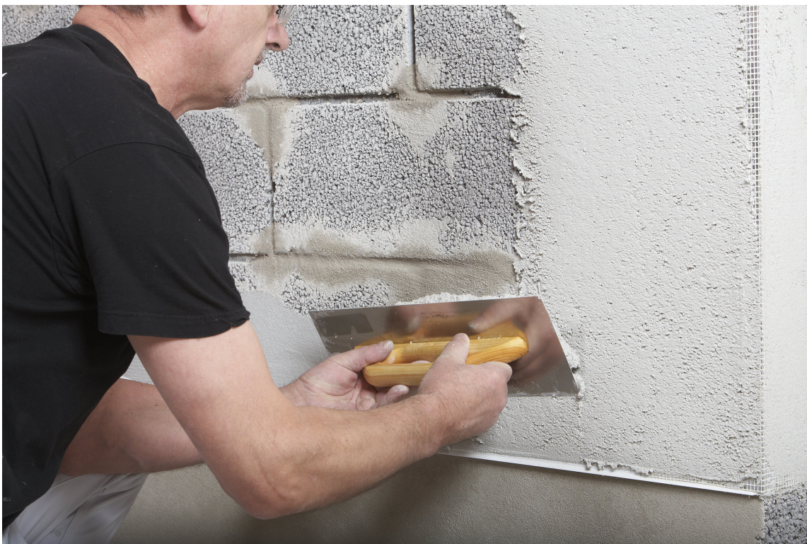
3. Legg på grunnpussen med et stålbrett. Skal du glatte ut en teglvegg, fylles fugene først med puss, og direkte etterpå påføres ytterligere et sjikt utenpå teglsteinen.
