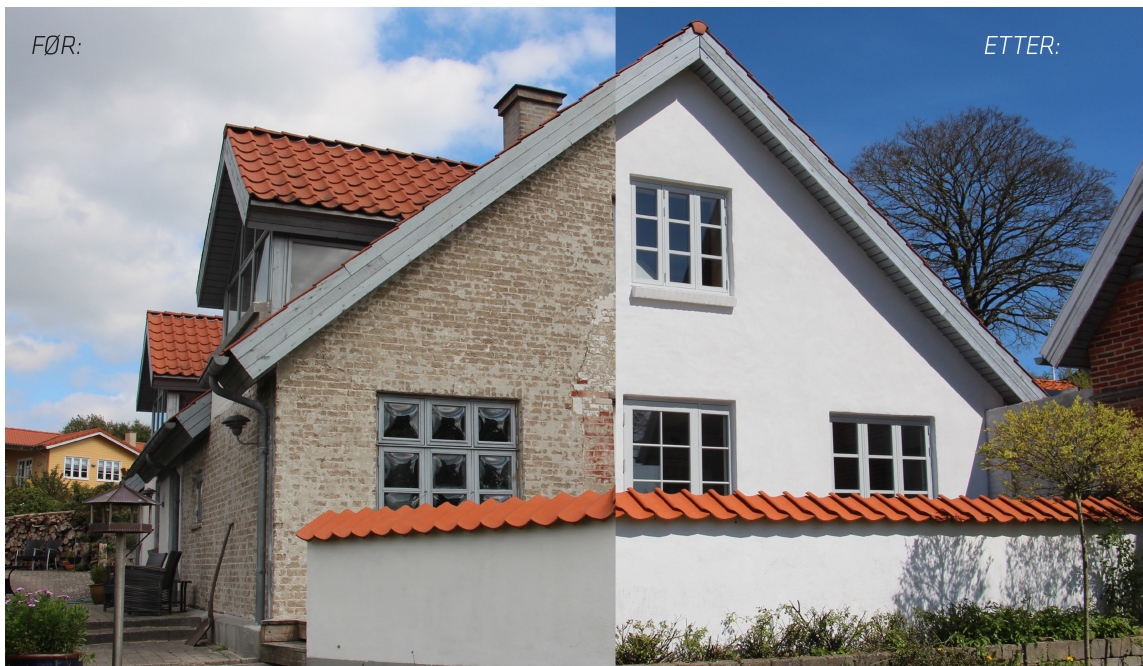
10. Den ferdige pussflaten kan brukes som den er, eller males i ønsket farge.
