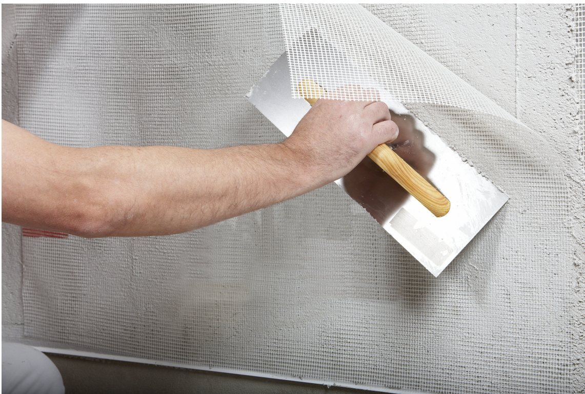
4. I den våte grunnpussen legges et armeringsnett. Nettet presses inn med stålbrett eller pussebrett.
