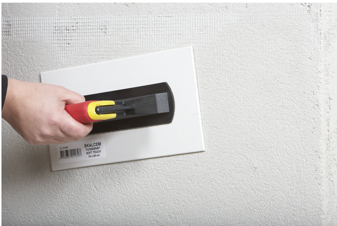
9. Etter noen minutter er overflaten tørr nok til å files lett med et pussebrett.
