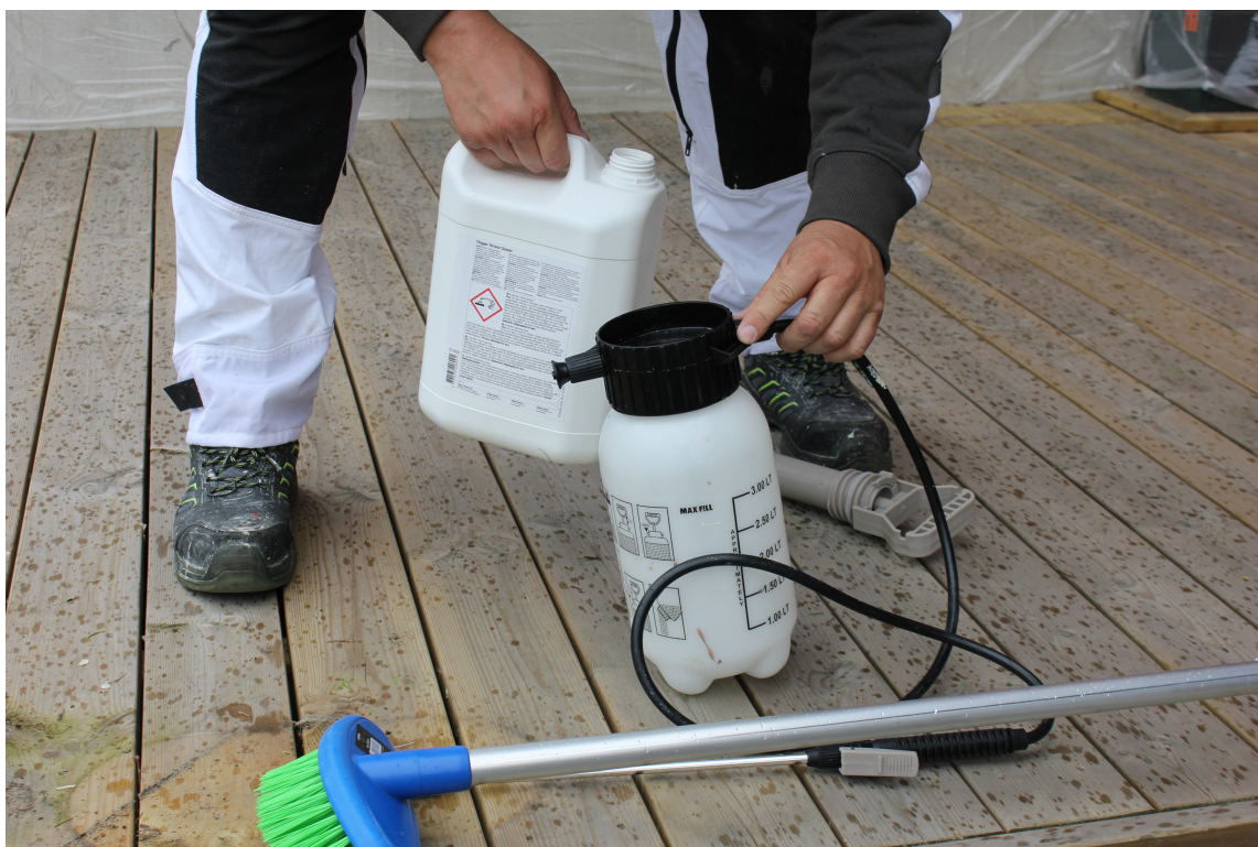
LAVTRYKKSPRØYTE: Det kan være smart å bruke en lavtrykksprøyte for å få en kontrollert påføring av rensemiddelet.
