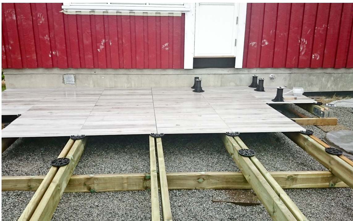
TREKONSTRUKSJON: Støttebeinene skrus fast i en bærekonstruksjon av tre, eller plasseres løst på et plant og hardt underlag.
