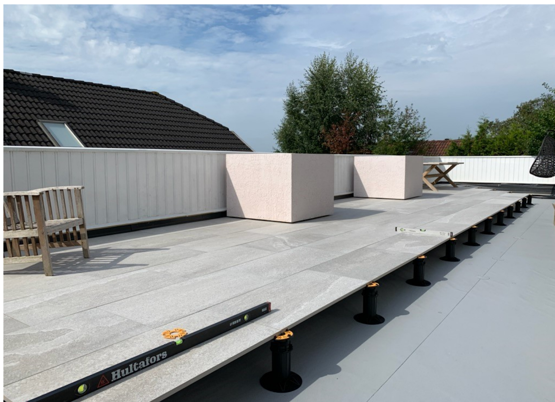
STORE FLATER: Det er i prinsippet ingen begrensninger for hvor store flater du kan bygge systemgolv med fliser over. Det er i stort sett uendelig.
