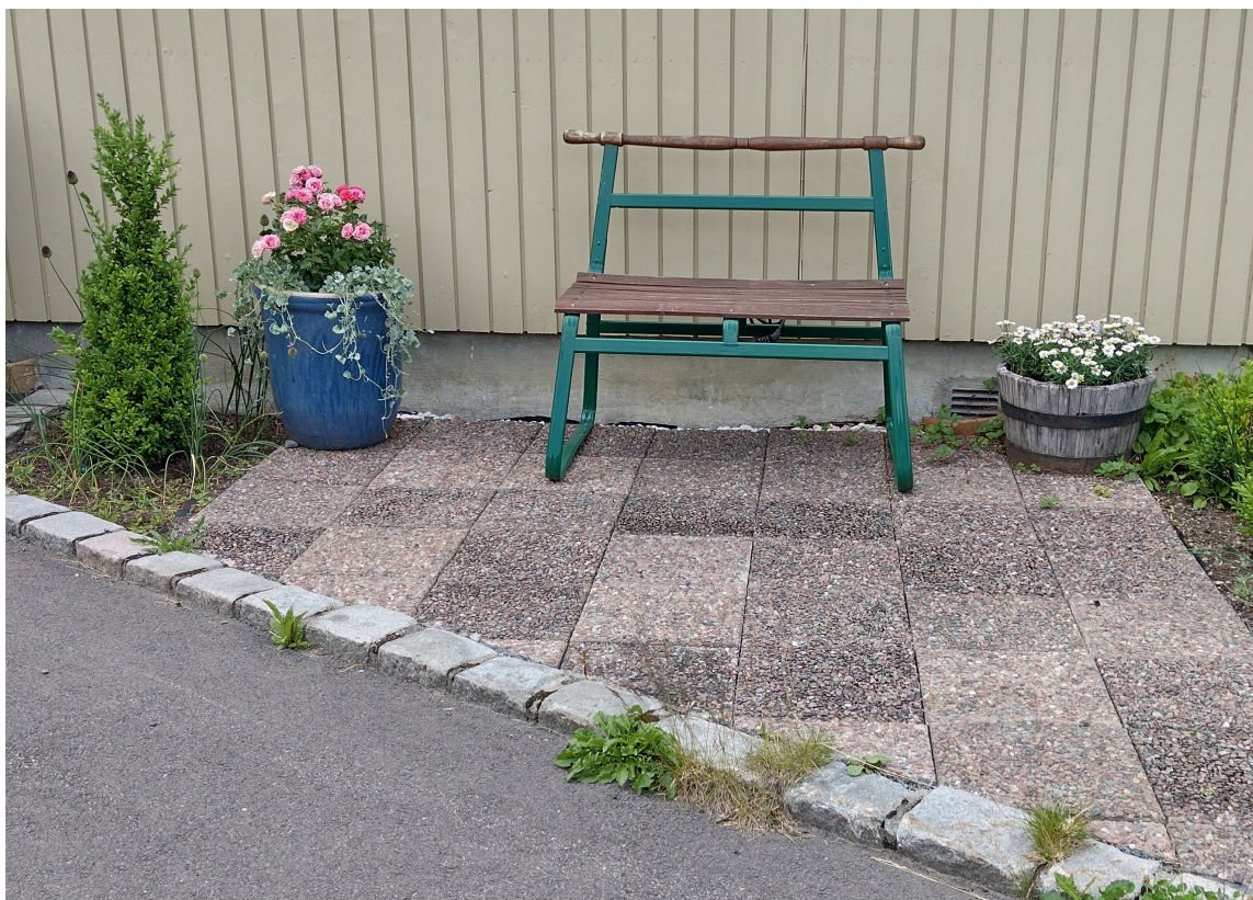
VEDLIKEHOLD AV UTEPLASSEN: Platting som har heller av naturstein kan også impregneres, i tillegg til belegningssteinen langs asfalten.
