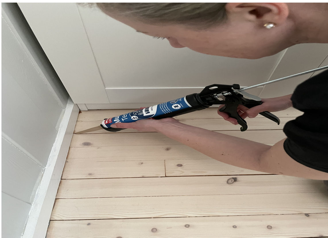
SPREKK VED GULVLIST: Er det blitt en glippe mellom gulvet og gulvlisten? Her er Casco MultiTech et godt verktøy. Tettmassen kommer i tre trefarger, samt hvitt, sort og to grå farger. Finner du ikke riktig farge, kan fugen males over.
