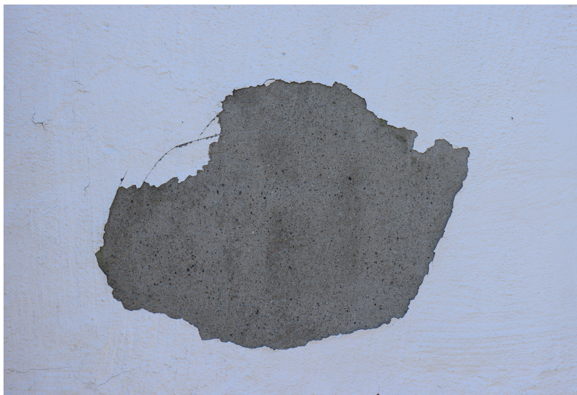
FØR OG ETTER: Slik så grunnmuren ut før reparasjonen
