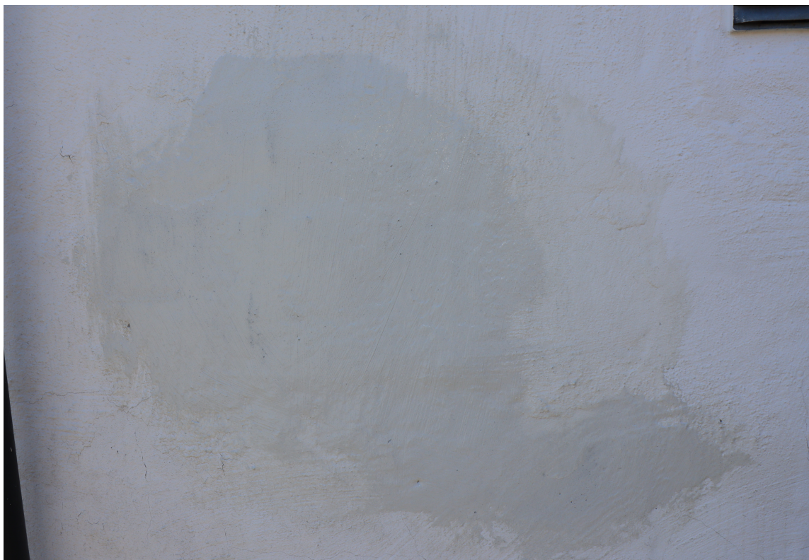
FØR OG ETTER: Slik ble grunnmuren etter reparasjonen.
